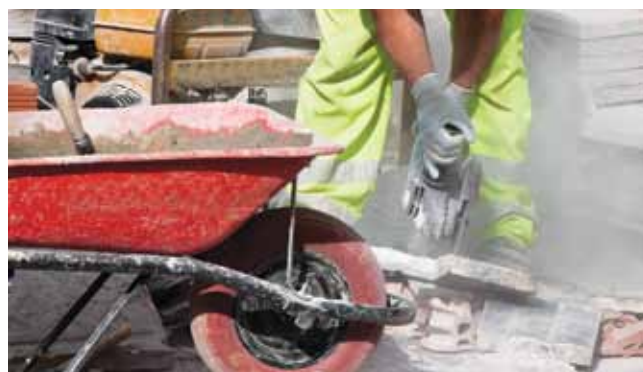
Hrup na gradbišču
