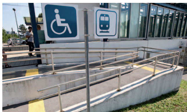
Klančina za dostop na železniški peron
