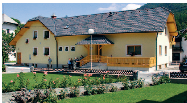
Večnamenski objekt ZDGNS v Kranjski Gori
