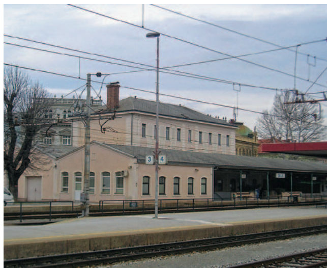
Železniška postaja Celje pred obnovo
